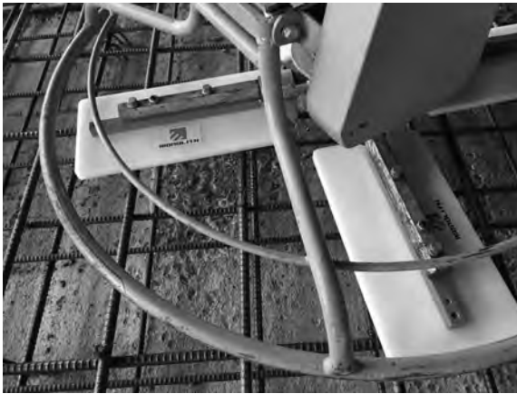
写真4 光沢レイヤー工法(KL工法)に用いるプラスチック鋺
