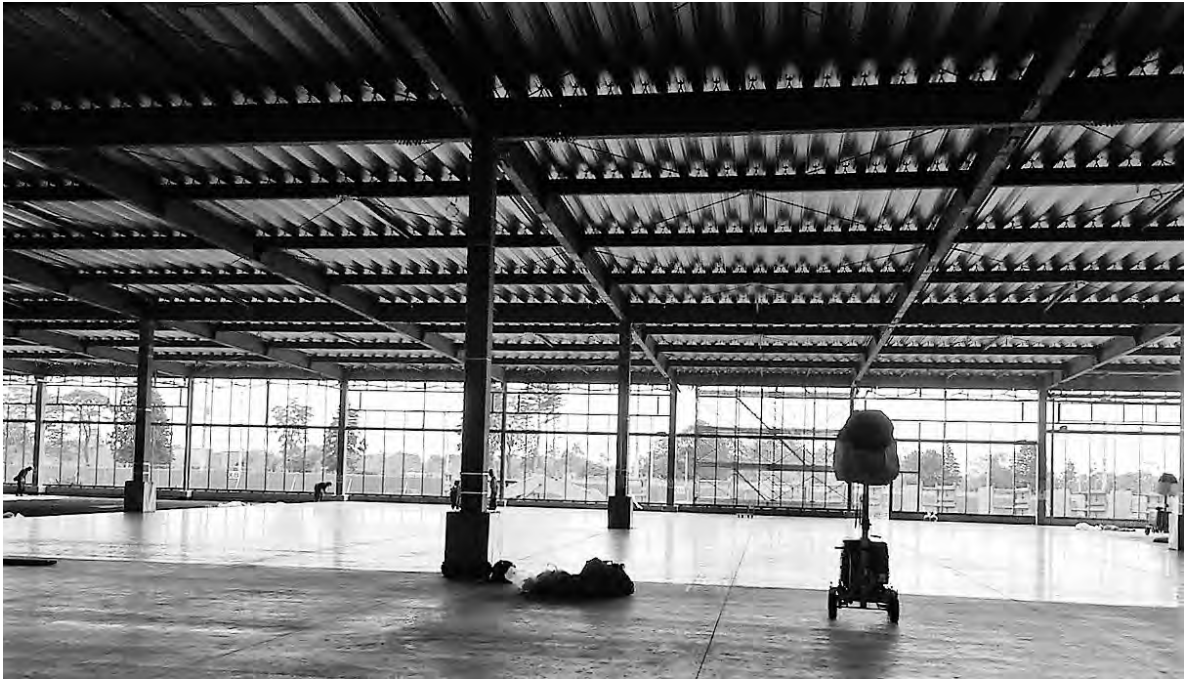
写真3 光沢レイヤー工法(KL工法)の仕上がり状況
