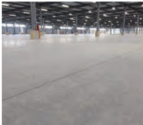
KL工法による床仕上げ
