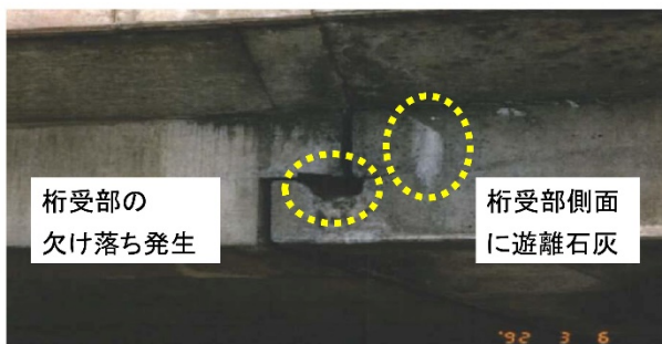
桁受部の状況(1992年)
